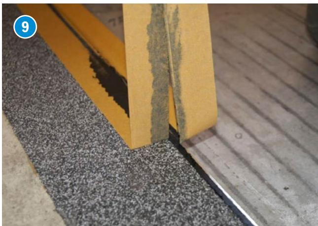
Fuge mit Polyurethan ausfüllen.
