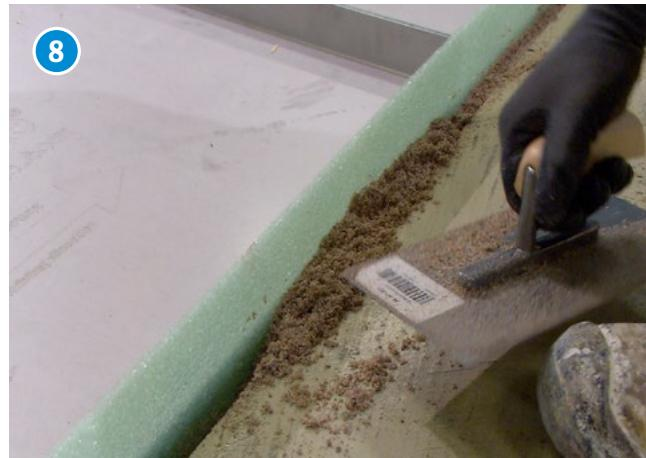
Spaltmaß zwischen Grubenrand und Wannen bündig vergießen, dabei Aussparung für Polyurethanfuge beachten, Füller/Kleber aushärten lassen.
