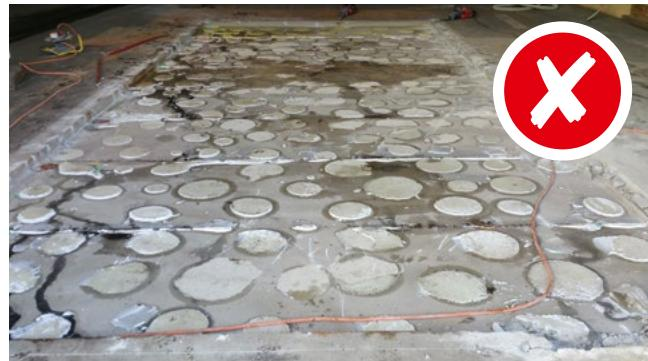
Wanne muss ganzflächig verklebt werden. Punktuelle Verklebung führt zu Unebenheiten, was ein Ausrichten der Wanne erschwert bzw. unmöglich macht.
