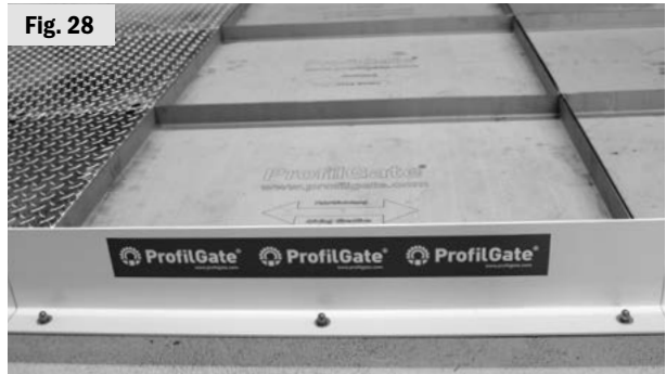
6. Visser les pattes de fixation latérales dans le sol.
