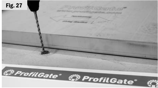
5. Préparer le vissage des angles de fixation.
