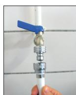
**2.** Schließen Sie den Schlauch mit dem Schlauchanschluß (0701) an den Wasserhahn.
