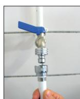
**2.** Vissez le tuyau avec le raccord rapide 1/2" (article n° 0701) sur le robinet d'eau.
