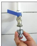
**1.** Montera ½" hinnippel på vattenkranen.
