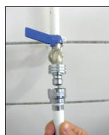
**2.** Klicka fast slangen med ½" snabbkoppling på vattenkranen
